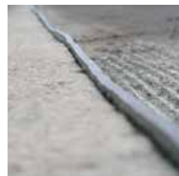
単純挿入、ロールアスファルトの5mmオーバーハング
